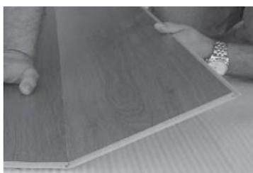
Para o encaixe no sentido transversal, é preciso utilizar o bloco batente com o martelo para encaixe dos topos. Depois de instaladas duas réguas no sentido longitudinal, dê suaves marteladas com o bloco no topo da régua, fechando os encaixes e deixando as réguas perfeitamente unidas. Seguir o mesmo processo a cada régua instalada até fechar a fileira próximo a parede.
