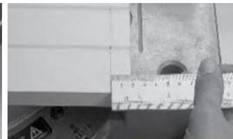
Após o corte, guarde o pedaço pequeno que sobrou, que deve ter um lado cortado em 45º e outro lado em 90º, pois esta peça será usada no acabamento de topo do rodapé. Vire a barra e corte o outro lado também em um ângulo de 45º, sempre a partir da face principal.
