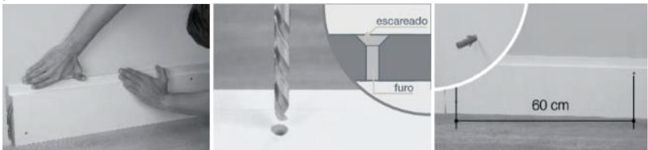
Em paredes de alvenaria, use broca de videa. Para que o parafuso e a barra fiquem totalmente firmes na parede, use buchas plásticas. Após colocá-las, posicione a barra na parede e faça a fixação final com parafusadeira ou chave de fenda.
