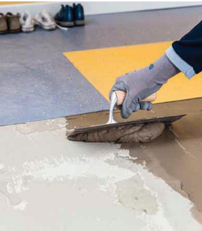
**Argamassa cimentícia monocomponente espalhada de secagem rápida (30 a 60 minutos) e alto rendimento para preparação da base em espessuras finas ou tamponamentos de buracos e/ou rampeamentos pontuais em até 25 mm.**
