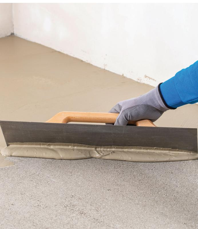
**Argamassa cimentícia monocomponente para regularização espatulada, de secagem normal (aproximadamente 24 horas) e alto rendimento, para preparação de substratos cimentícios absorventes em camadas finas, em pisos e paredes, inclusive em áreas molhadas.**
