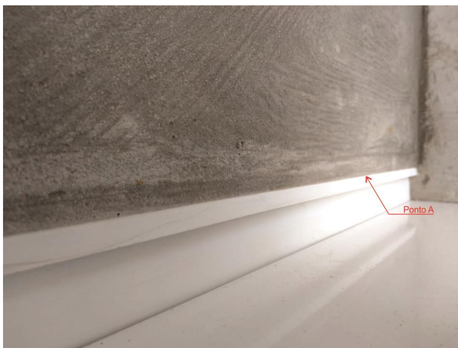
Figura 3 – Rodapé Neo Alumínio instalado.
