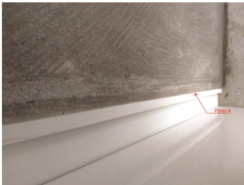
Figura 3 – Rodapé Neo Alumínio instalado.
