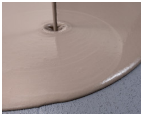
Aplicação de argamassa autonivelante sobre Eco Prim Grip Plus curado em piso antigo
