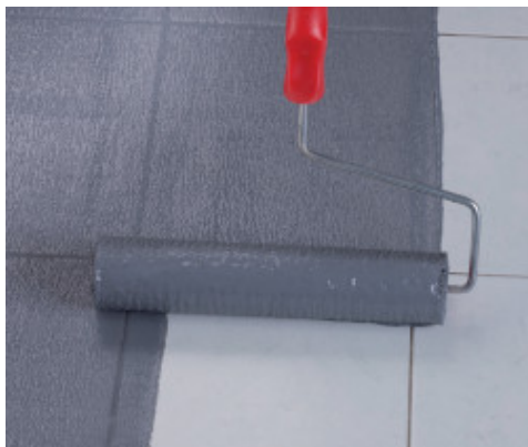
Aplicação de Eco Prim Grip Plus com rolo sobre porcelanato existente
