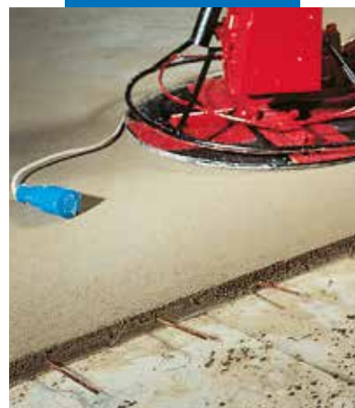
Acabamento superficial com helicóptero
