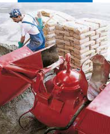
Massa de Topcem com equipamento automático de bombeamento
