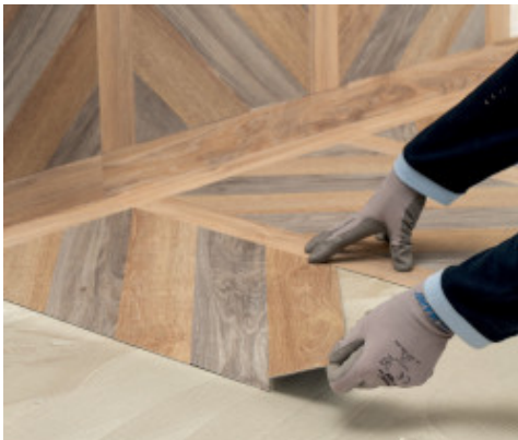
Aplicação de LVT modular com Ultrabond Eco V4 Evolution
