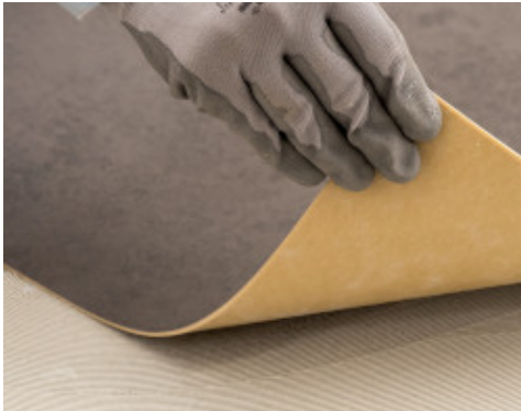
Aplicação de revestimento com base poliuretânica com Ultrabond Eco V4 Evolution
