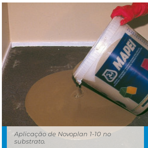
Aplicação do Novoplan 1-10 com espátula metálica e/ou rodo graduado sobre o contrapiso de cimento com Primer G.
